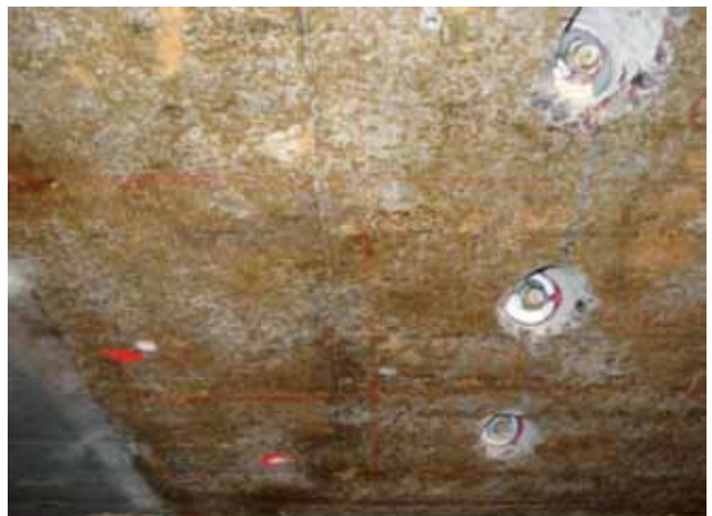
Рис.17. Установленные в плиту анкеры
