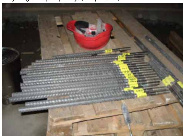
Рис.21. Промаркированные стержни, подготовленные для вклейки в отверстия
