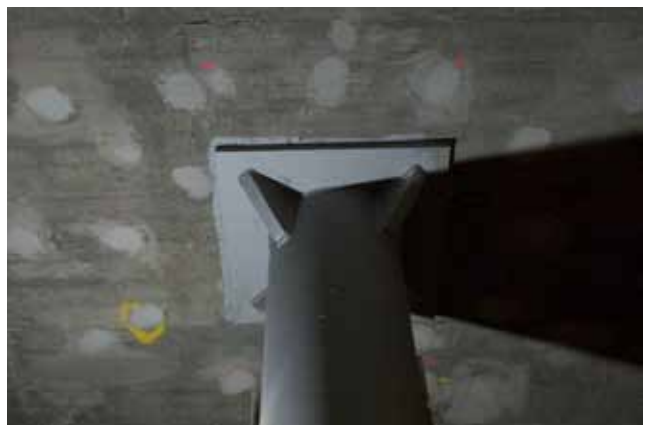
Рис.18. Вид снизу на плиту перекрытия после проведения работ по усилению.
