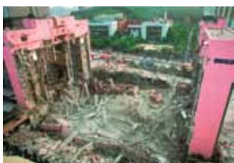
Рис.2. 25 Июня 1995 года. г. Сеул. Причиной последовательного обрушения плит перекрытий стало продавливание колонной верхней плиты перекрытия и последовательное, полное обрушение
