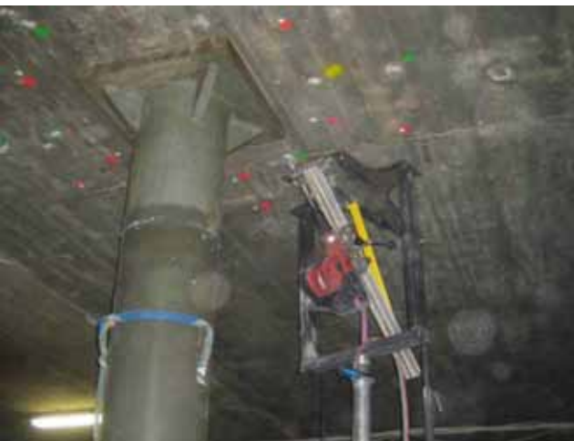
Рис.15. Бурение отверстия в потолке под углом 45°
