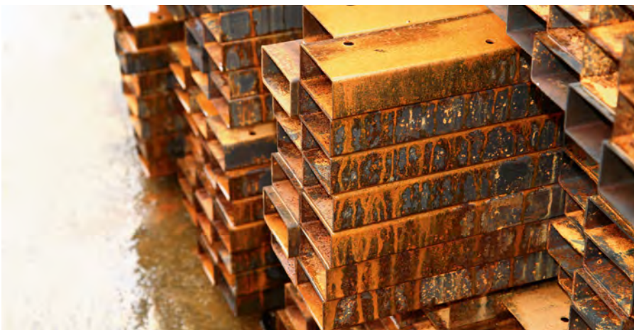
Рис. 4. Коррозия на изделиях из стали.
